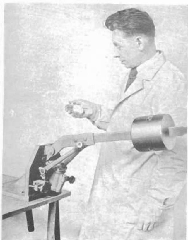
Abb. 55. Prüfung des Stoßdämpfers
